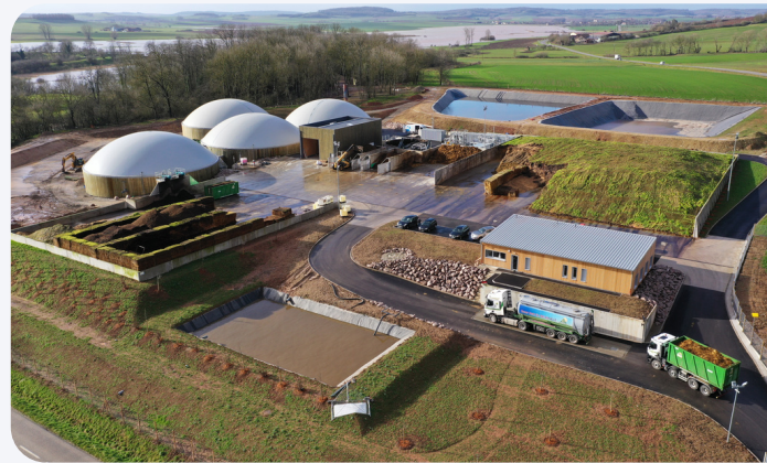
Site de méthanisation où sera implanté un pilote de captage de CO 2 biogénique développé par l'entreprise Carbon Impact, à Haraucourt sur Seille ( Grand Est ).
